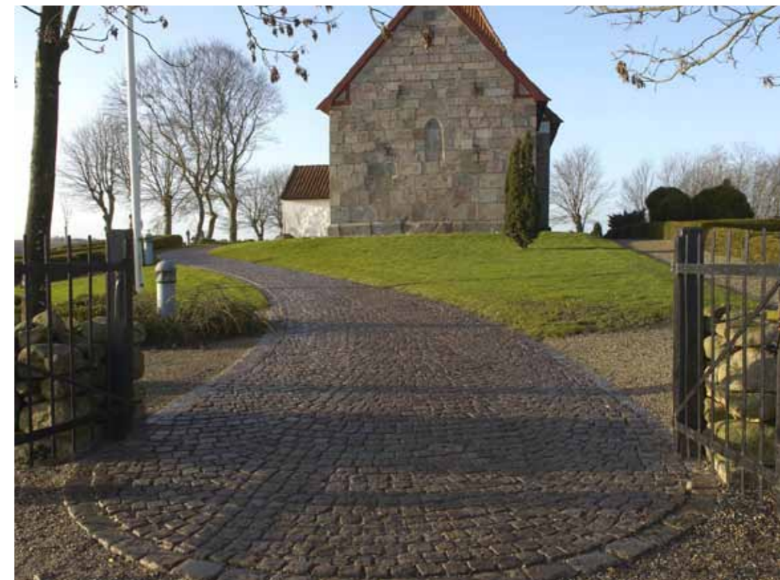
Sti af slidte nordiske chaussésten i faglig korrekt udførelse. Græsribatter. Kragelund Kirkegård
