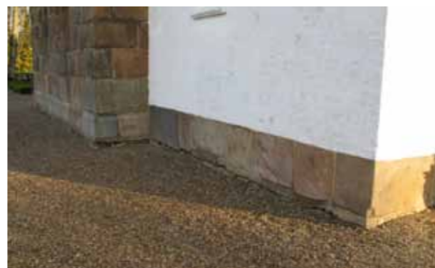
Terrænniveau ligger under sokkelsten omkring kirken
